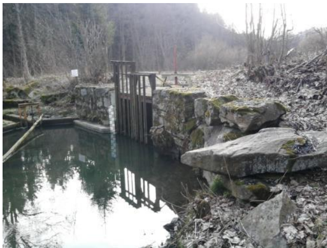
Vlevo detail vtokového stavidla, vpravo celkový pohled na vtokovou část podzemního potrubního přivaděče
