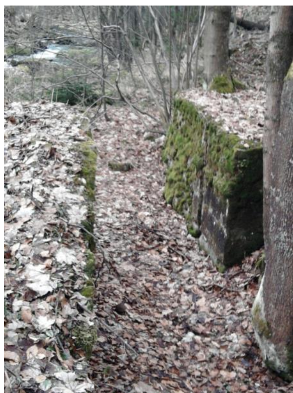
Vlevo detail klenby nad vyústěním odpadní štolý v západním průčelí, vpravo zbytky vtokového stavidla náhonu
