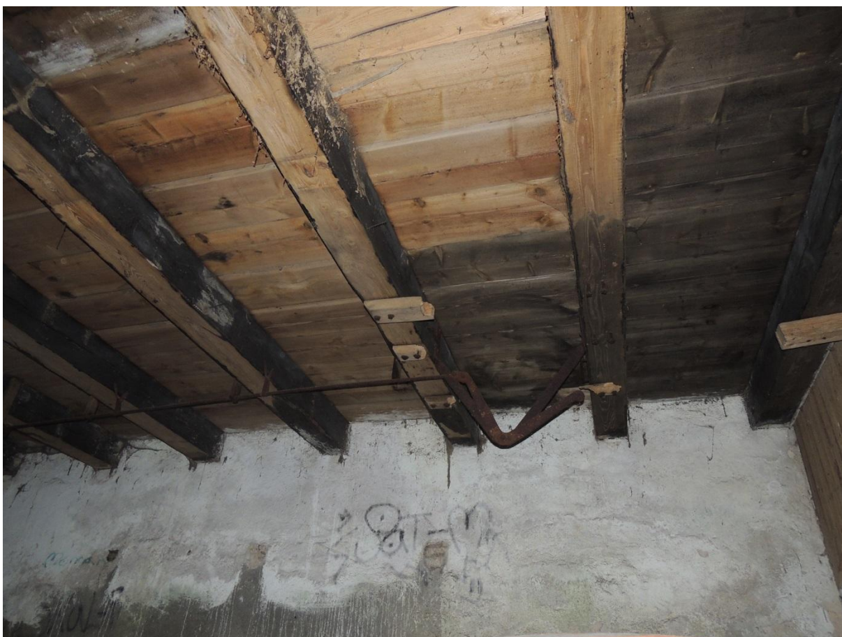
Zbytky ovladačů výtokových klapek na stropě strojovny vodních kol
