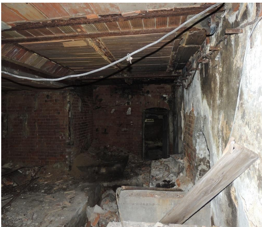
Kotelna-původní zdivo a nový silně zbastlený strop ze 70 let
