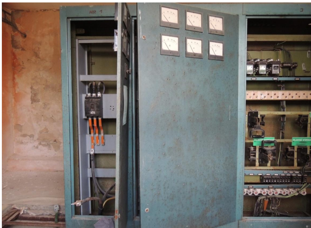
Torzo hlavního rozvaděče v rozvodně
