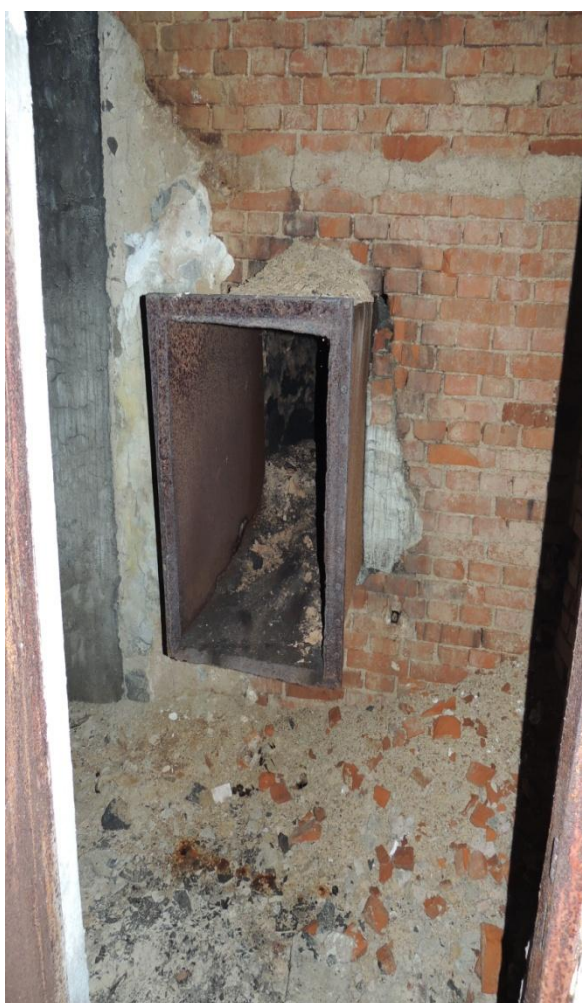
Zaústění kouřovodu do komína v místnosti kouřovodu v přízemí
