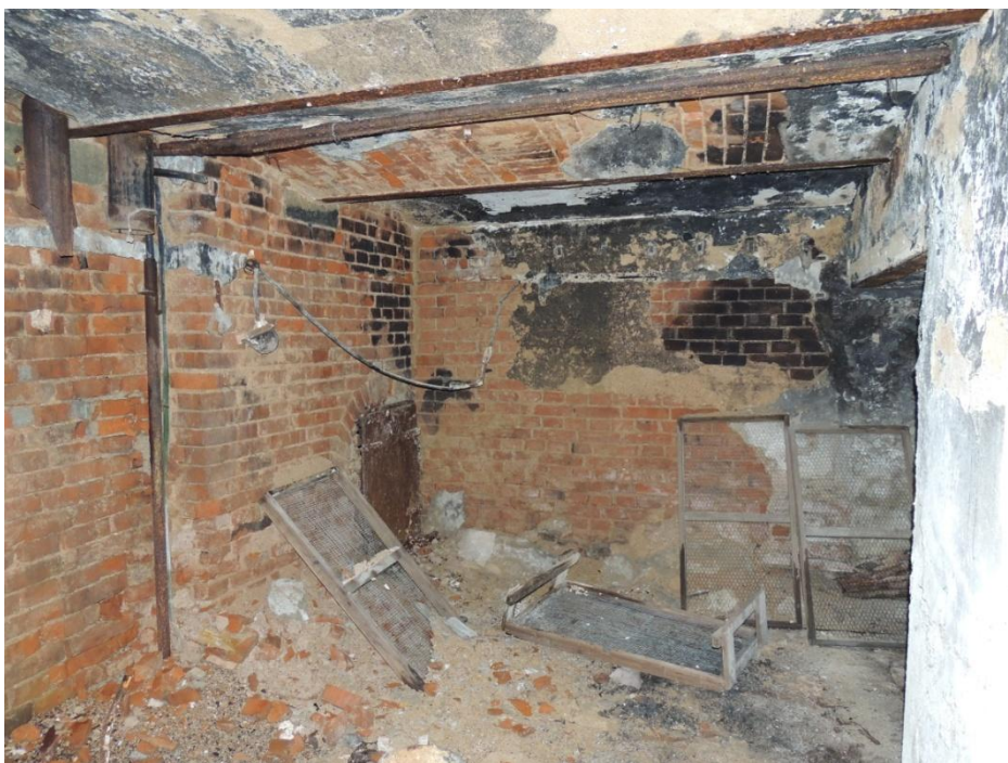
Místnost elektrokanálu-pata komína s vybíracím otvorem a zbytky původních kleneb
